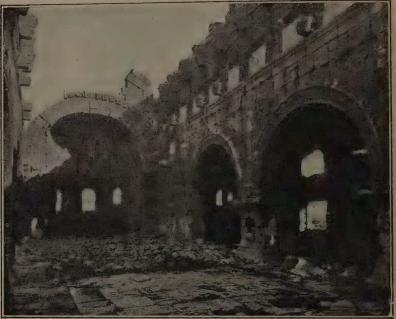
Fig. 3. — Église de Qalb-Louze. Intérieur (d'après Butler).
